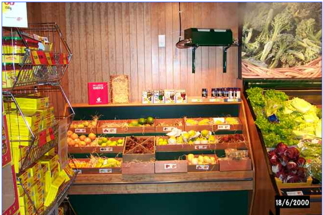
Grundbefeuchtung der Grünzone in einem kleinen Supermarkt mit geringen Warenumschlag. Besonders hier ist die Befeuchtung sehr wichtig.
